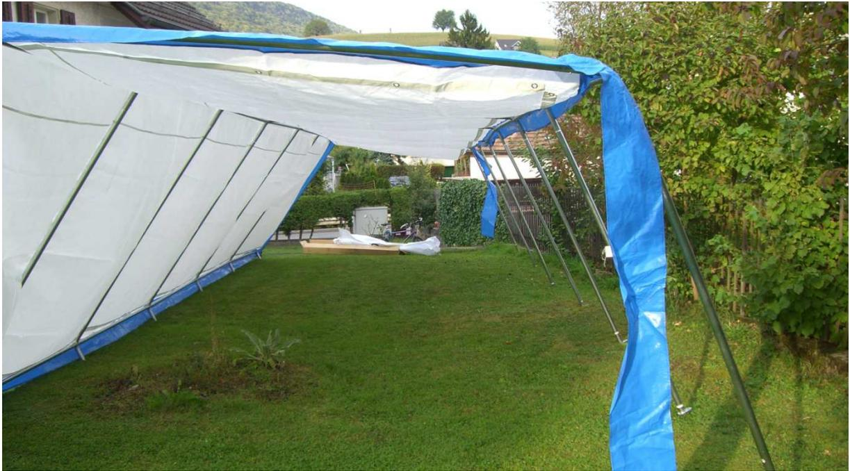
**Bild 6:** Das Zelt ist somit bereit um angehoben zu werden. Es sollten mindestens 4 Personen gleichzeitig anheben. Nun können die restlichen Stützen Nr. 3 + 4 angebracht werden.
